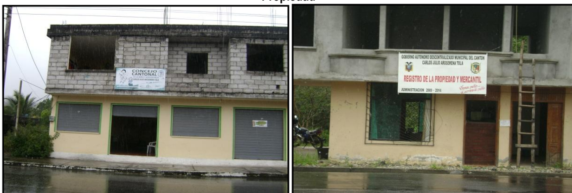
Fotografía 2. 39 Instalaciones del S.N.D. de Protección Integral de la Niñez y Adolescencia y Registro de la Propiedad
