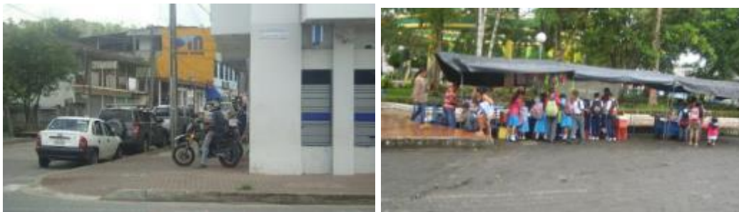
Foto 6: Uso inadecuado del espacio público: aceras
