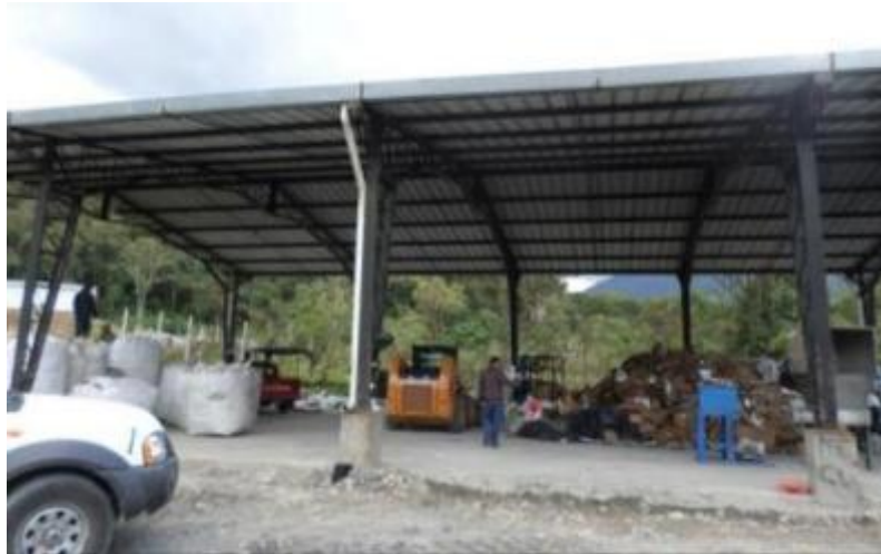
Fotografía N 5 Actividades Relleno
